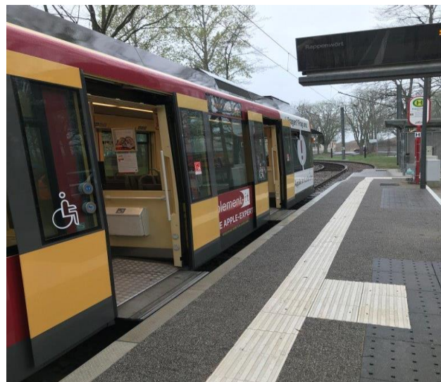
Abbildung 3: Haltestelle Rappenhörth taktiler Einstiegsfeld, Foto: Holger Wagensommer
