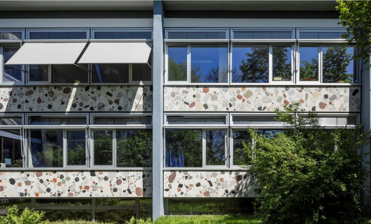
Max-Planck-Gymnasium: geregelte Nachtauskühlung
