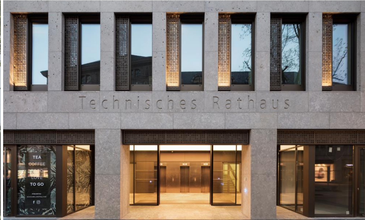
Technisches Rathaus: Klappen zur manuellen Lüftung
