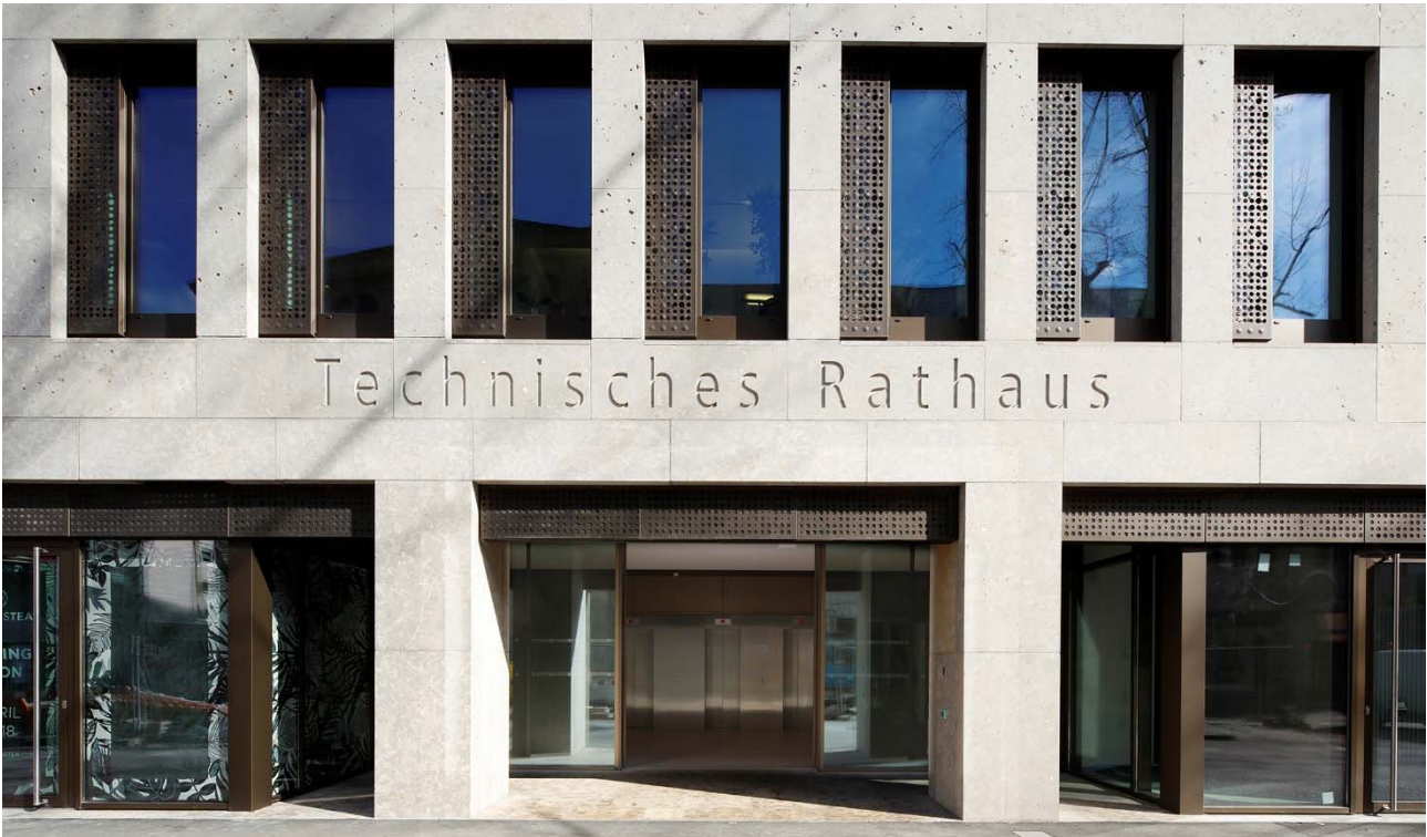
Abbildung 28: Nachtlüftungsklappen an den Fenstern des technischen Rathauses erlauben, nachts kühlere Luft ins Gebäude zu leiten, ohne dass Fenster ungesichert offenstehen. Foto: Atelier Dirk Altenkirch.
