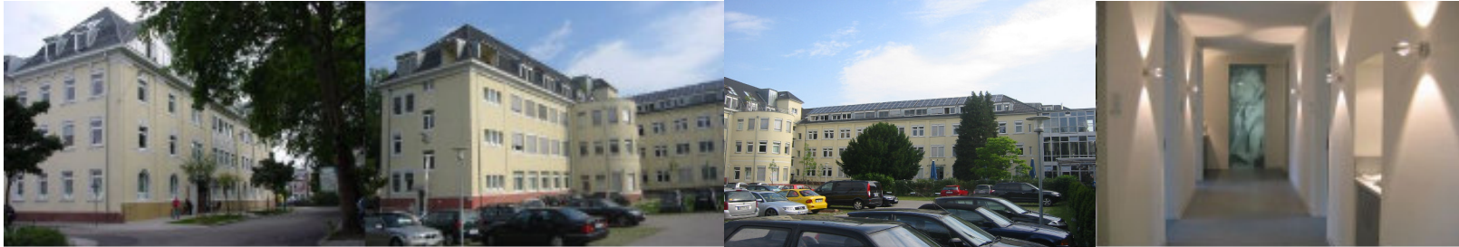
Gritznerstraße, Durlach – 4400 qm – Revitalisierung, Kernsanierung
