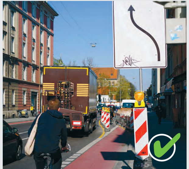
Bild 15 | Arbeitsstelle auf Radfahrstreifen durch Abspernung gesichert
