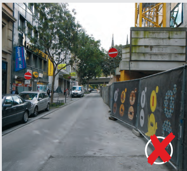
Bild 1 | Arbeitsstellenbedingte Einbahnstraße nicht eindeutig für Radverkehr freigegeben
