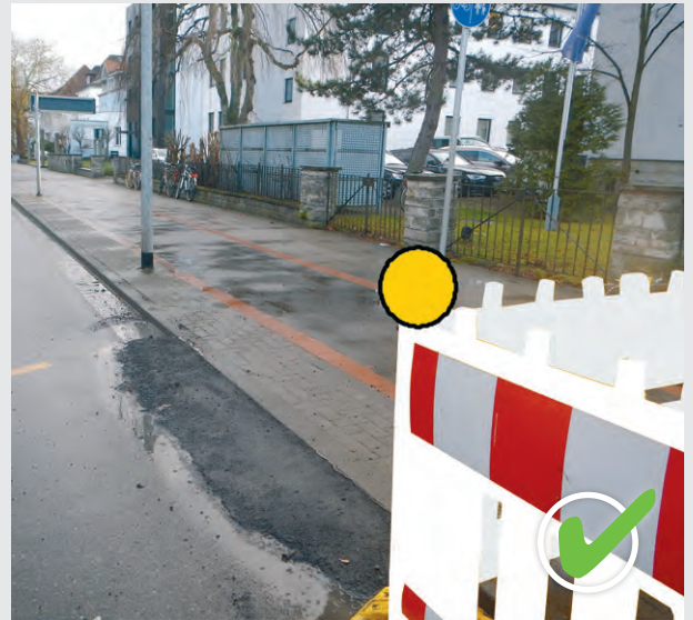
Bild 7 | Anrampung in Form von Asphaltkeil hergestellt
