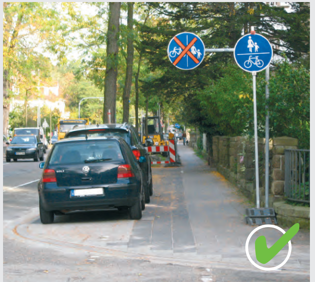
Bild 17 | Außer Kraft gesetzte Verkehrszeichen sind durch Auskreuzvorrichtungen zu kennzeichnen. Der Einsatz von Klebeband ist verboten. (Auf die unzureichende Dimensionierung des abgebildeten Geh- und Radwegs wird hingewiesen.)
