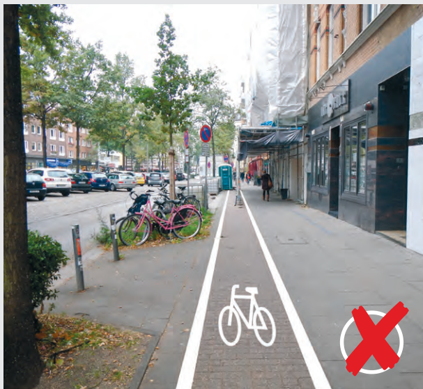
Bild 12 | Gerüst auf Radweg mit schlecht sichtbarer Sicherung
