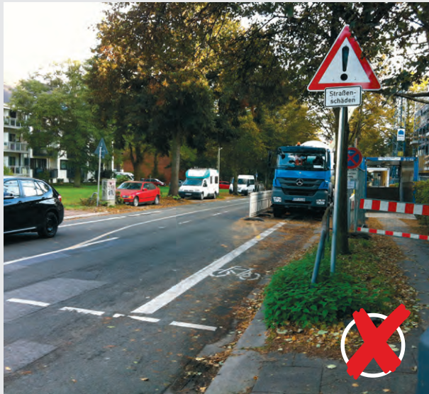
Bild 14 | Arbeitsstelle auf Radfahrstreifen ohne Absicherung
