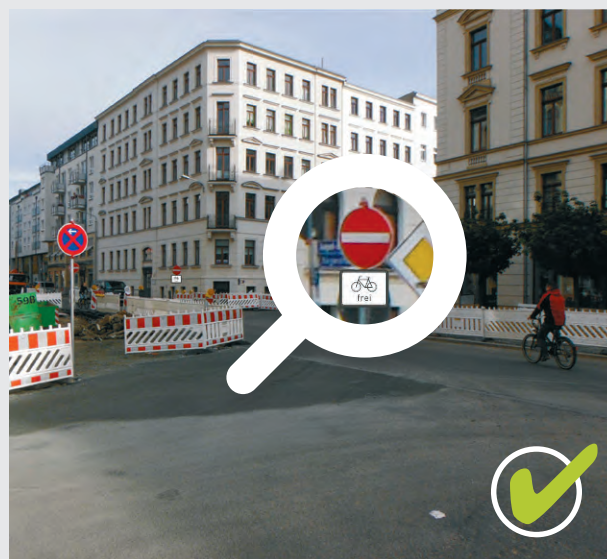
Bild 2 | Arbeitsstellenbedingte Einbahnstraße für Radverkehr freigegeben
