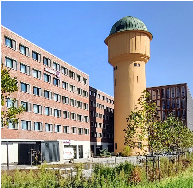
Blick auf das neue Gebäudepaar, Foto: Stadtplaungsamt
