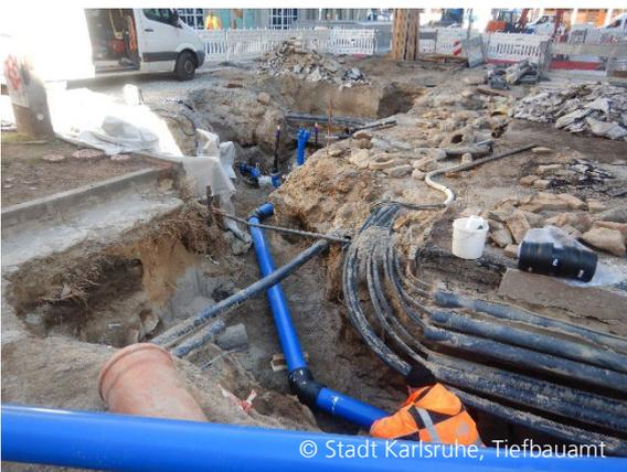
Abbildung 9: Leitungsbauarbeiten für Strom, Straßenbeleuchtung, Wasserversorgung und Veranstaltungsinfrastruktur
