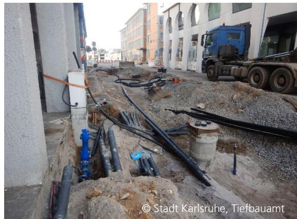
Abbildung 10: Karl-Friedrichstraße - Leitungsbauarbeiten für Strom, Straßenbeleuchtung, Veranstaltungsinfrastruktur, Gas-, Wasser- und Fernwärmeversorgung
