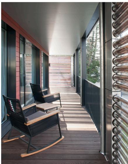
Integrierte Solarthermie in Balkonzone am Beispiel eines Dreifamilienhauses, Zürich-Höngg (kämpfen für architektur ag)
