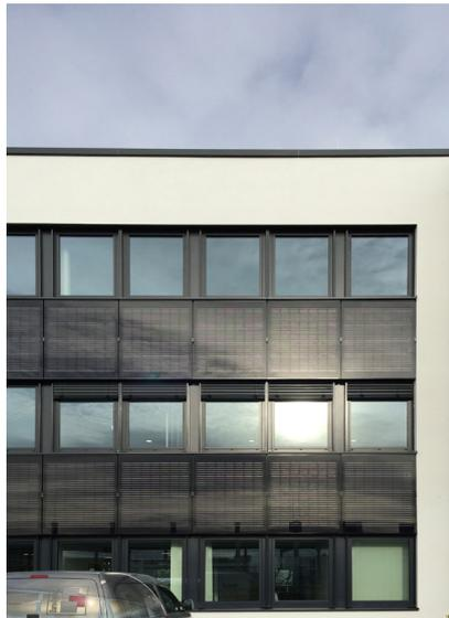
Photovoltaik-Module in Fassade integriert
