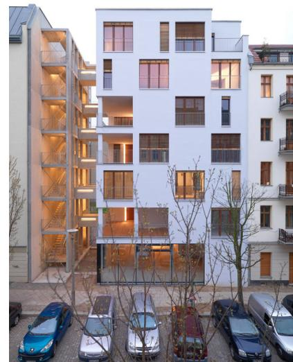
Skelettbau mit Stahlbeton-Treppenhaus, freistehend, und Holzmassivbauelementen am Beispiel e3, Berlin (Kaden und Klingbeil)
