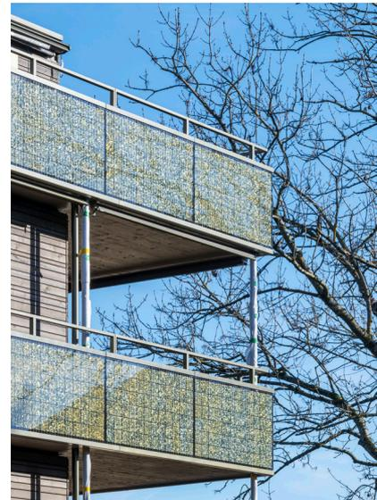
Integrierte Photovoltaik in Balkongeländern am Beispiel eines Mehrfamilienhauses, Zürich-Altstetten (kämpfen für architektur ag)
