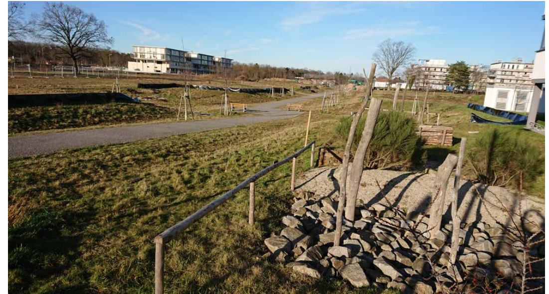
Flache Mulden nur bei oberflächennaher Einleitung oder Einleitung der angrenzenden Flächen und Gebäude realisierbar
