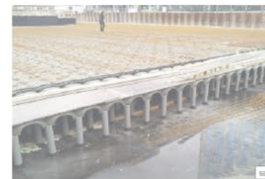
R2.4 Füllkörperrigolen
