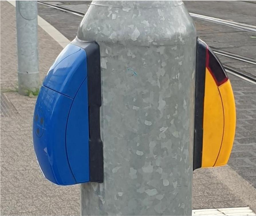
**Abbildung 15: Signalgeber mit akustischen und optischen Signalen und Vibrationstaste, Haltestelle Tullastraße.**
