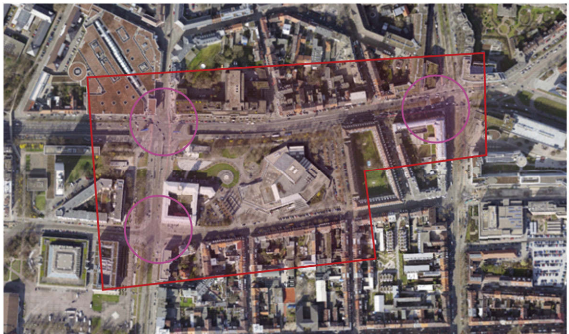
Abbildung 3: Untersuchungsraum vor Beginn der Baumaßnahmen Kombilösung
