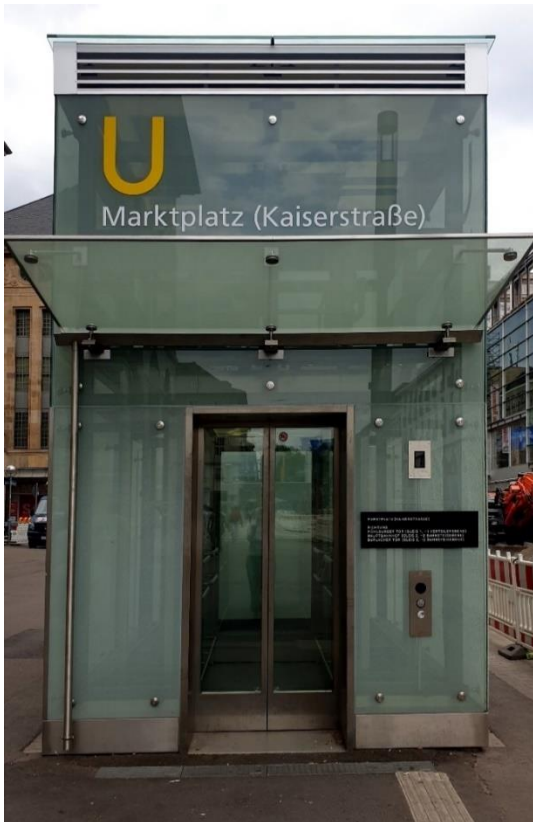
Abbildung 12: Zugang mit Aufzug zur U-Station, Mundhaus Marktplatz.
