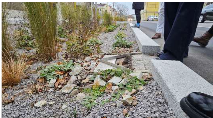
Abb. 17: Sickermulden in St. Pölten (A).
