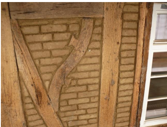
Fassadenansichten: Ausmauerungen mit Lehmziegeln
