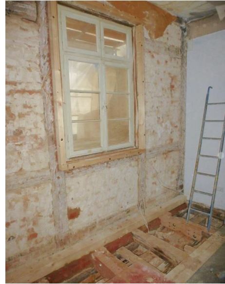
Büro OVS Deckenhölzer u. Nordwand
