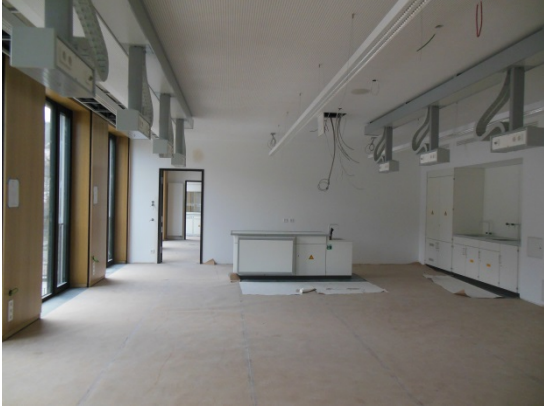
Bauteil C, NWT-Räume
