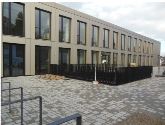
Außenanlagen Bereich Staigstraße
