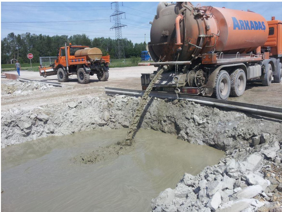
Abbildung 2-2: Abpumpen von flüssigem Material in ein Erdbecken
