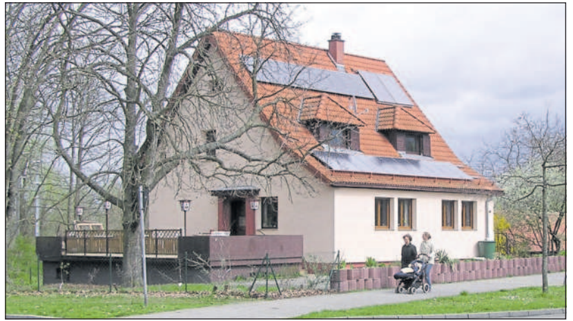
Das Gasthaus „Zum neuen Jägerhaus“ (später nur noch „Jägerhaus“) ist heute ein Wohnhaus. Foto: Anke Hüper, Stadtarchiv
