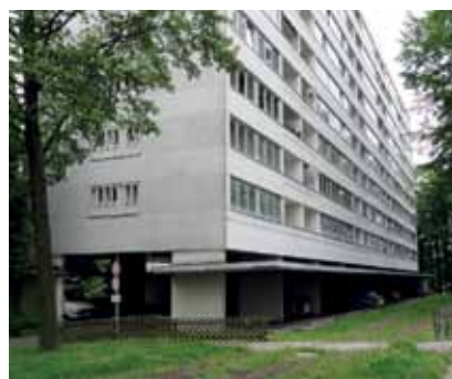
1 Vorfeld der Wohnhochhäuser
