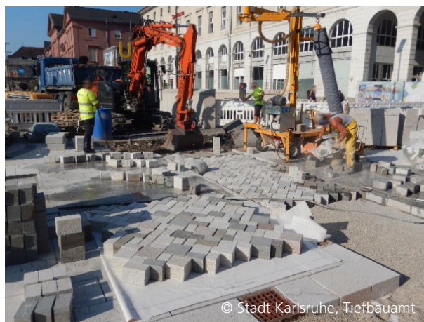
Abbildung 5: Pflasterverlegung im Sommer 2023
