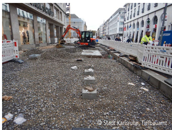
Abbildung 3: Fundamente für künftige Fahrradständer
