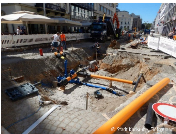
Abbildung 3 und 4: Leitungsbau Gas und Wasser sowie Entwässerungsrinnen als Begrenzung des zukünftigen Zierbands
