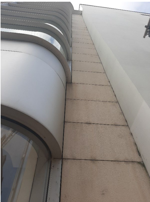
Abbildung 5: Übergang zwischen Modehaus (links) und Parkhaus (rechts)
