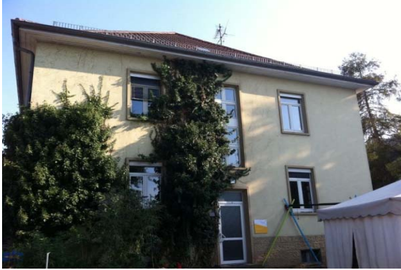
Bild 1: Verwaltungsgebäude Wolfartsweierer Straße 11 - NW-Fassade Immissionsort IO 1: EG
