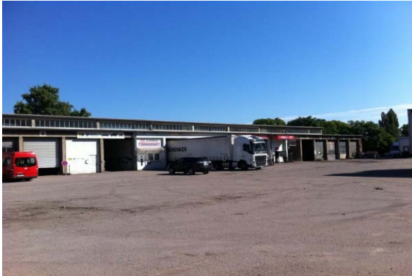
Bild 19: Gelände Wolfartsweierer Straße 11 Bestandsgebäude (geplanter Abriss), Südfassade Freifläche vor Bestandsgebäude
