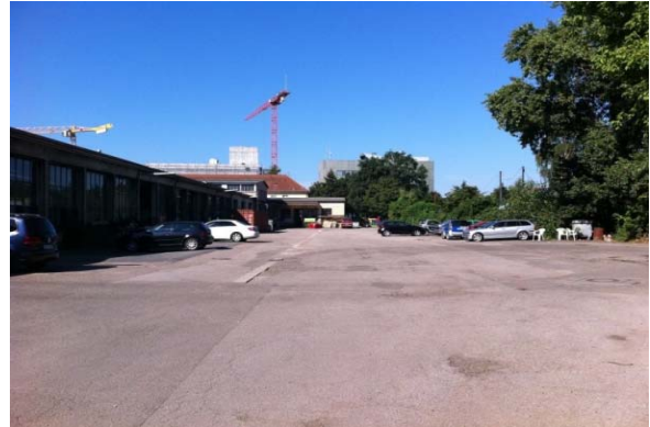
Bild 20: Gelände Wolfartsweierer Straße 11 Freiflächen nördlich der Bestandsgebäude Blick nach Westen
