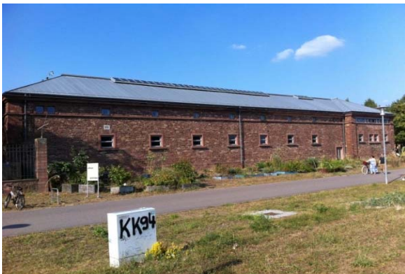
Bild 9: Hochschulgebäude Institut für Musiktheater Am Schloss Gottesau 17, Südfassade Immissionsort IO 7: EG - DG
