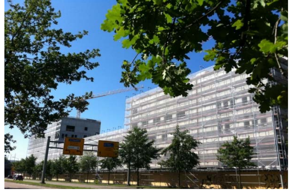
Bild 2: Neubau Hauptfeuerwache, Wolfartsweierer Straße 30 - 36 NO-Fassade
