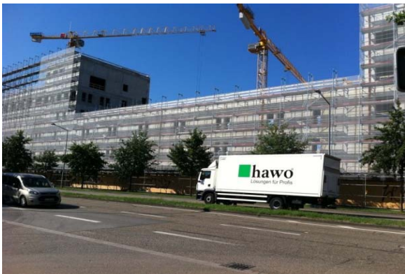
Bild 3: Neubau Hauptfeuerwache, Wolfartsweierer Straße 30 - 36 NO-Fassade, Mitteltrakt mit Ruheräumen Immissionsort IO 2: 1. OG - 2. OG
