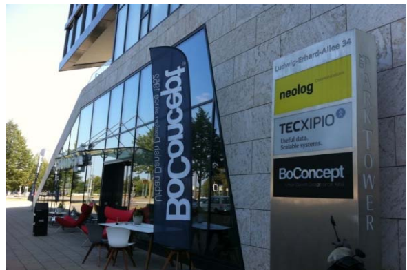
Bild 6: Wohn- und Bürogebäude Ludwig-Erhard-Allee 34 NW-Fassade Ladennutzung im EG - Möbelgeschäft BoConcept
