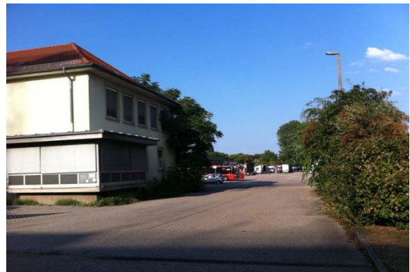
Bild 16: Gelände Wolfartsweierer Straße 11 Ein- und Ausfahrt und Verwaltungsgebäude
