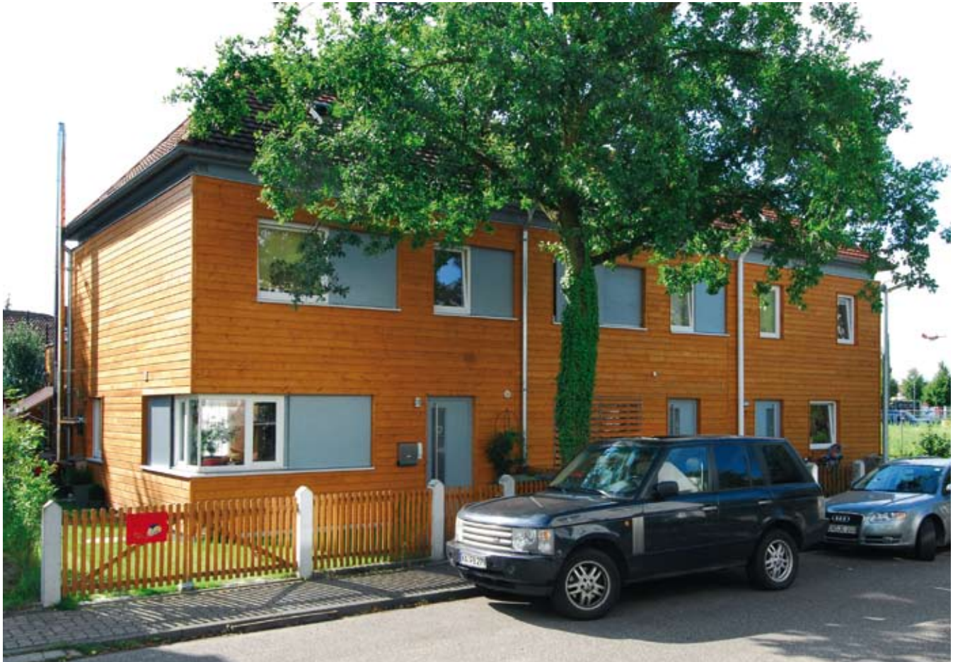
1 Neubauten ergänzen den erhaltenen Bestand
