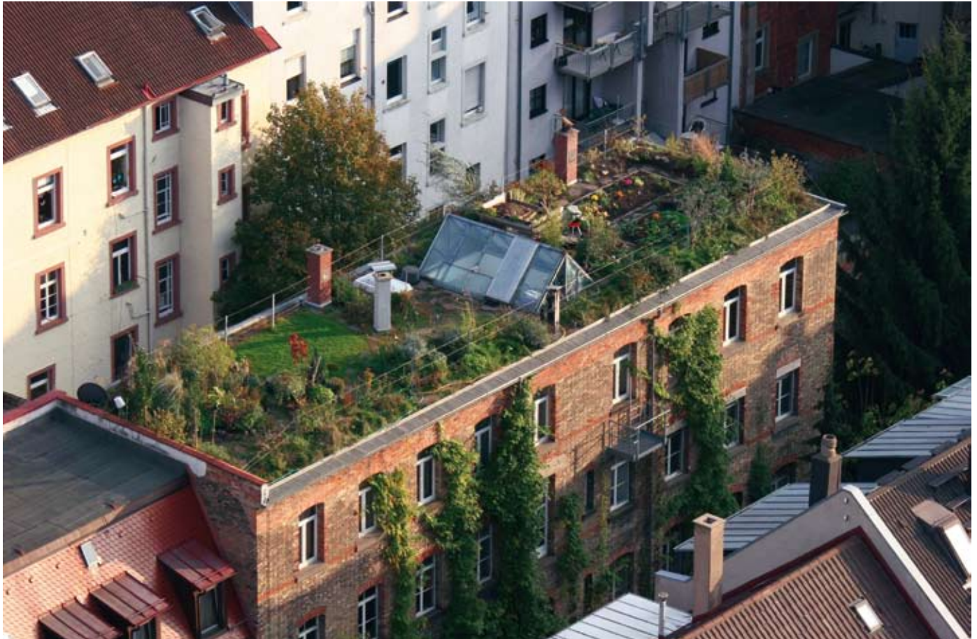
5 Ein Dachgarten eines Gebäudes in der Lachnerstraße; Neue Funktion des Flachdaches - umgebaut auch ohne städtische Förderung. Neue Aufenthaltsqualität „on top“!
