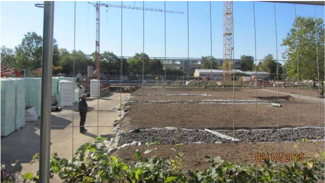
Der Freiraumbereich um die spätere Nord-Süd-Achse in der Bauphase (Bereich über der Tiefgarage; BN 3)
