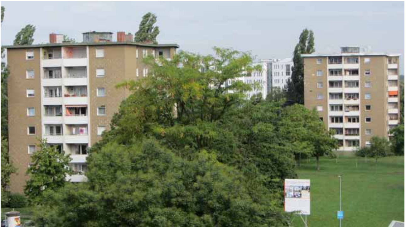
Heilbronner Straße 17 und Hirtenweg 6 vor Sanierung (BN 3)
