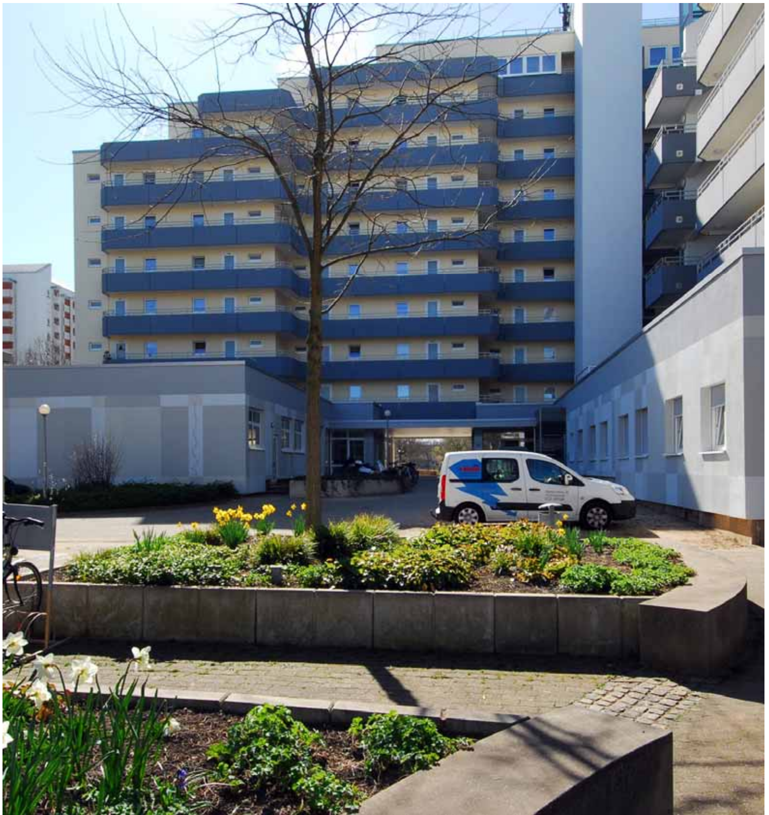
Heinz-Schuchmann-Haus (nach Modernisierung) BN 1
