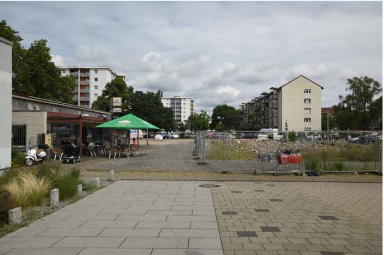
Staudenplatz nach (Teil)Abbruch (BN 1)
