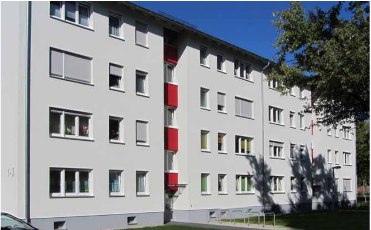
Heilbronner Straße 1-3 nach der Sanierung (BN3)
