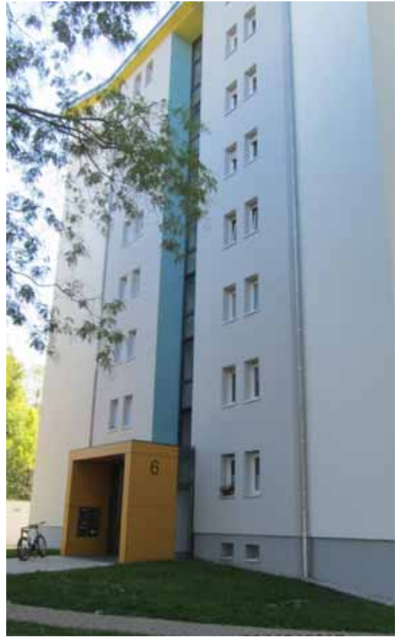
Hirtenweg 6 nach Sanierung (BN 3)
