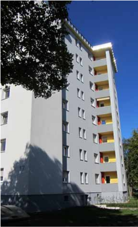
Heilbronner Straße 17 nach Sanierung (BN 3)
