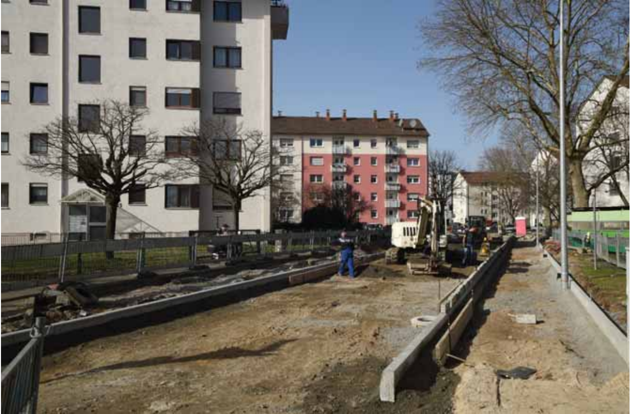
Heilbronner Straße Richtung Staudenplatz (östl. Bereich während des Umbaus; BN 3)
