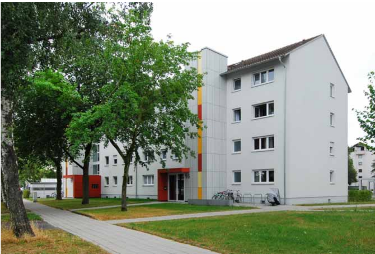
Beispiele für modernisierte Gebäude der Volkswohnung am Hirtenweg (Ausführung erfolgte damals vor Sanierungsgebietsaufnahme; BN 1)
