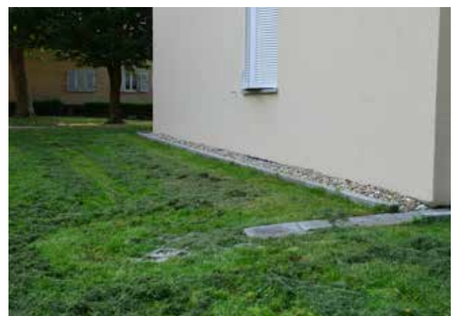
Abgedichtete Regenwasserzuleitung, Untermühlsiedlung
